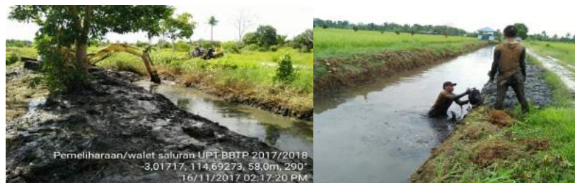
Gambar 3.3 Pembuatan dan Pembersihan Saluran
