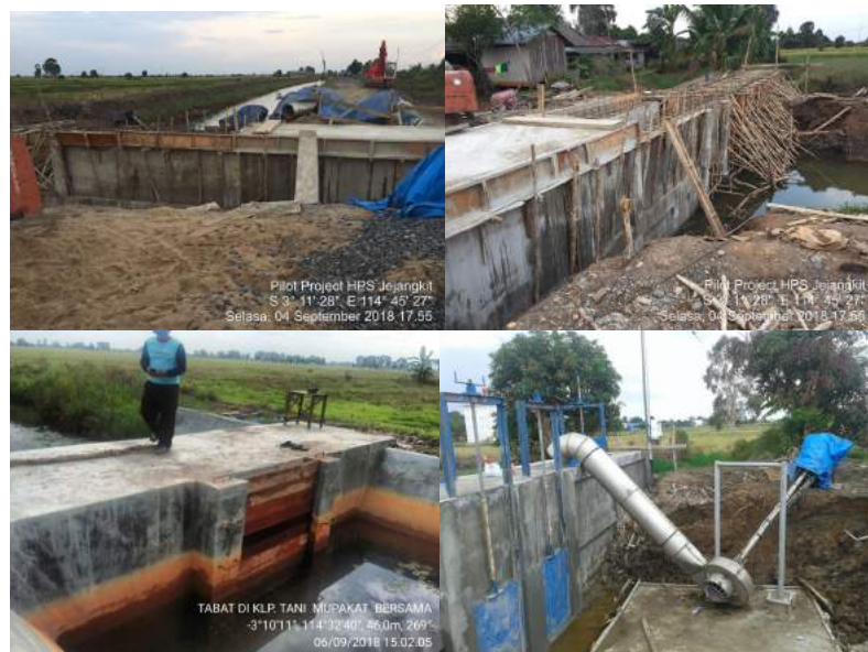
Gambar 3.17 Kegiatan Pembuatan Pintu Tabat dan Saluran Pembuangan
