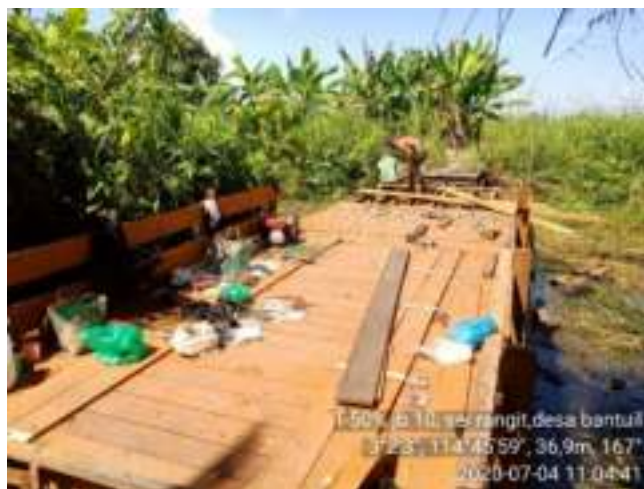
Gambar 3.32 Kegiatan Pembangunan Jembatan
