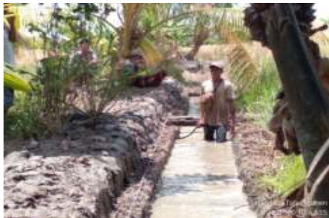
Gambar Pembuatan Saluran Tersier (Saluran Mikro)
