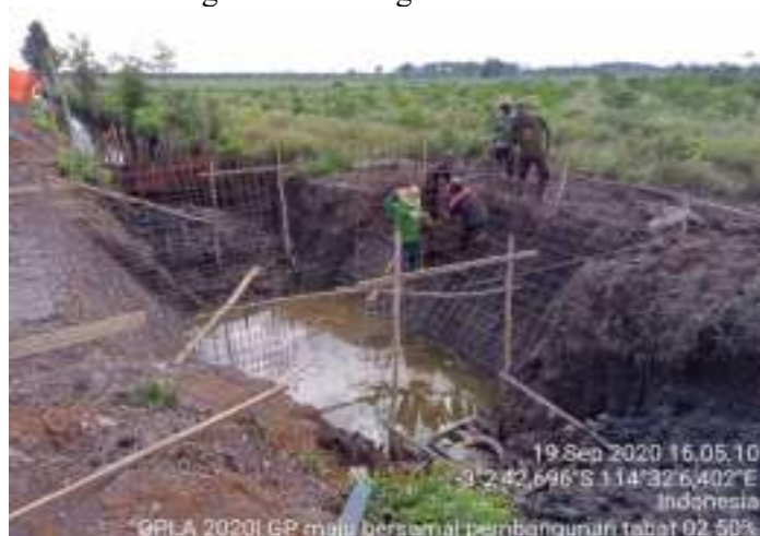
Gambar 3.33 Kegiatan Pembangunan Pintu Air
