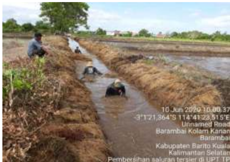
Gambar 3.4 Pemeliharaan Saluran
