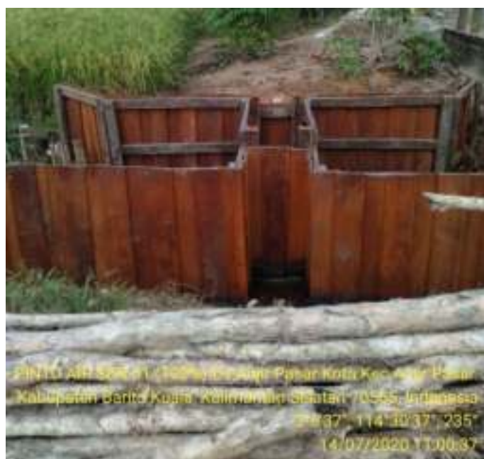
Gambar 3.39 Pembuatan Pintu Air Sederhana
