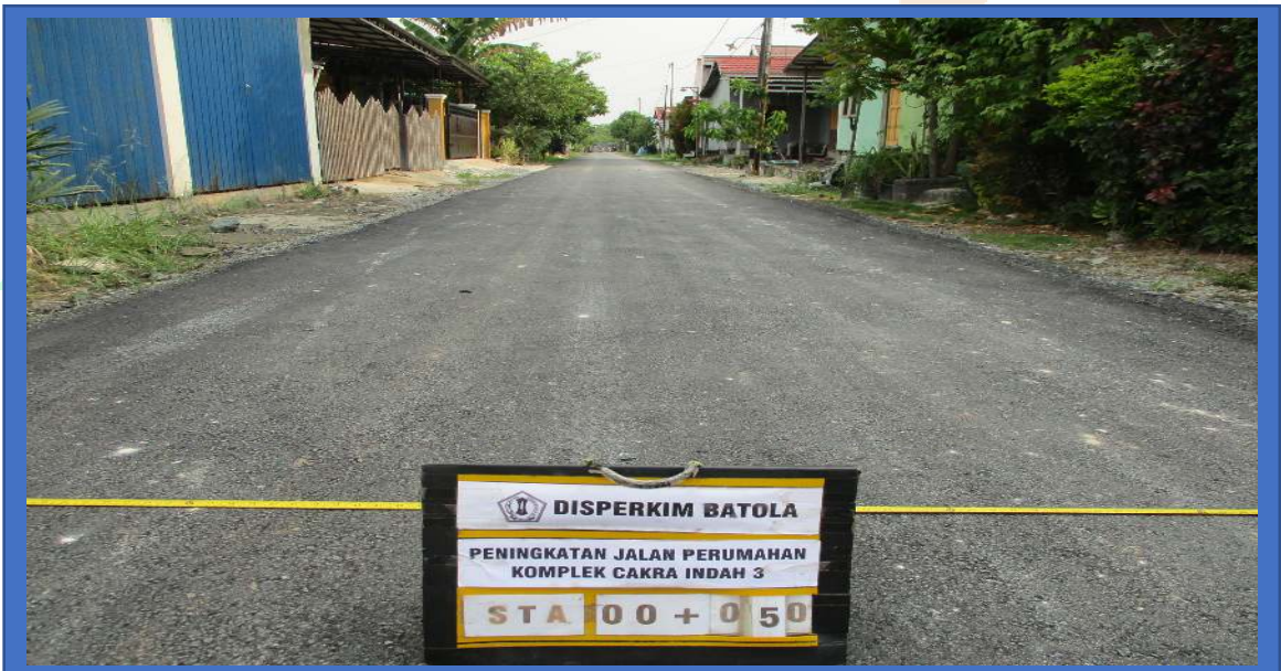
Gambar 15. Peningkatan Jalan Perumahan Komplek Cakra Indah 3
