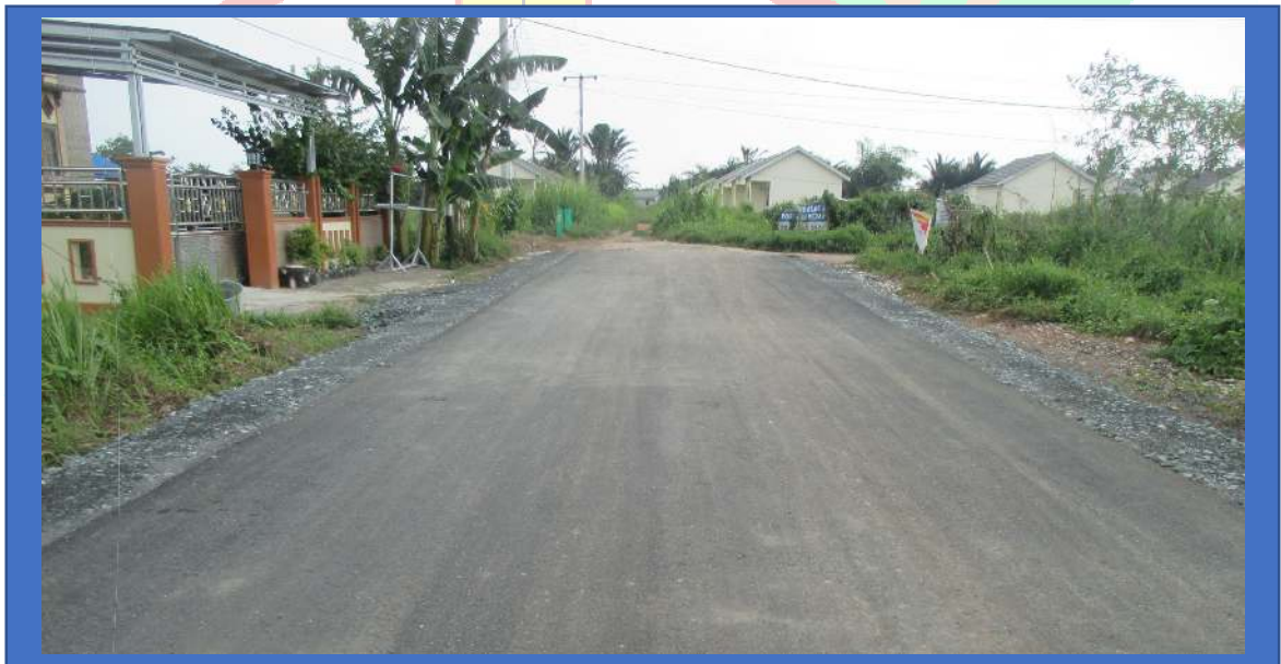
Gambar 13. Peningkatan Jalan Komplek Wira Bakti
