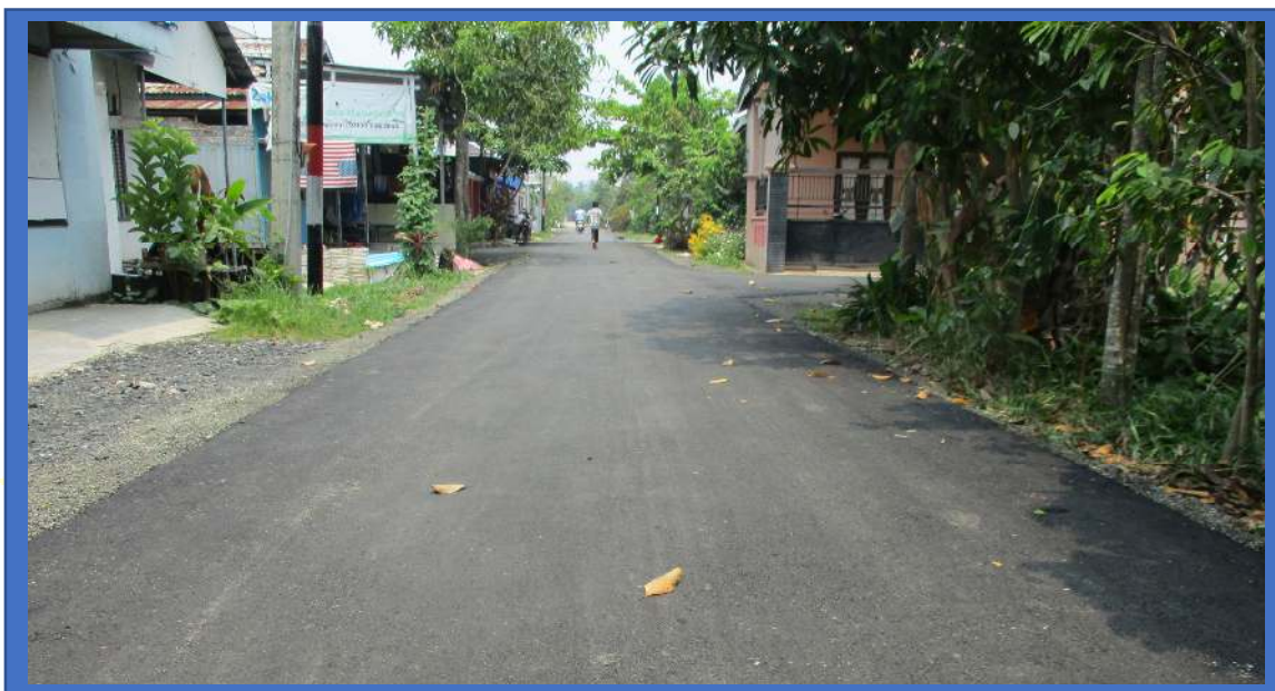
Gambar 16. Peningkatan Jalan Komplek Persada Permai RT. 32
