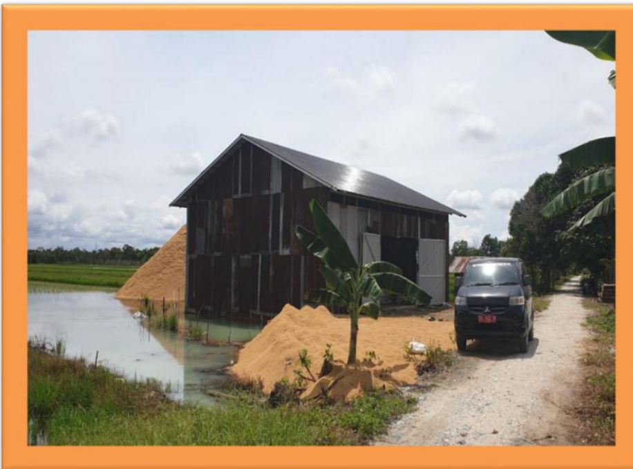
Ket : Survey Izin Mendirikan Bangunan (Imb) Dan Izin Usaha Penggilingan Padi Ud. Hr. Barokah An. Herianto
